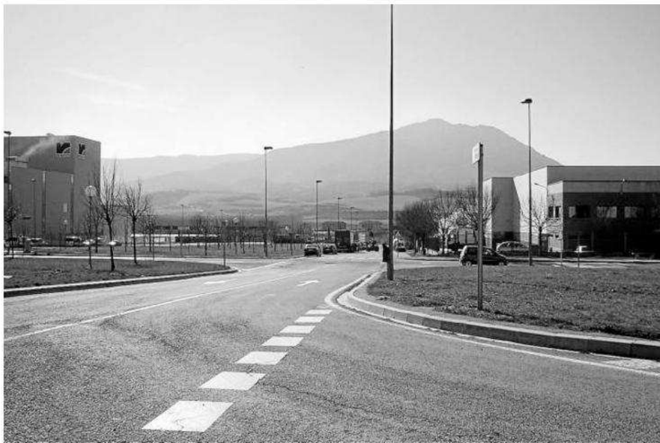
Vista del polígono industrial San Miguel en Villatuerta. Foto: C.S.
